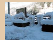
④センター玄関前の積雪
